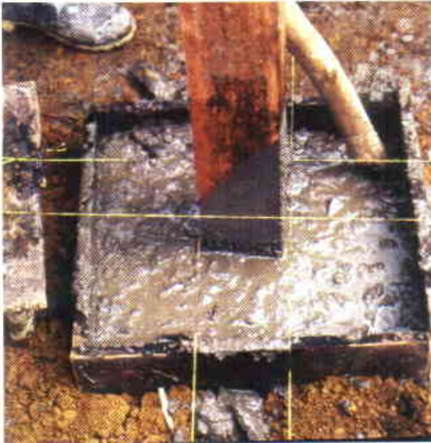
Figura 16. Fundición de columna
