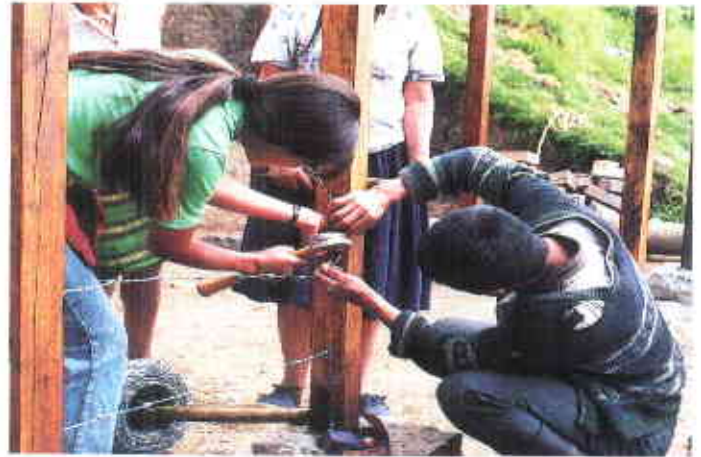
Figura 21. Templado y clavado de alambre de púas
