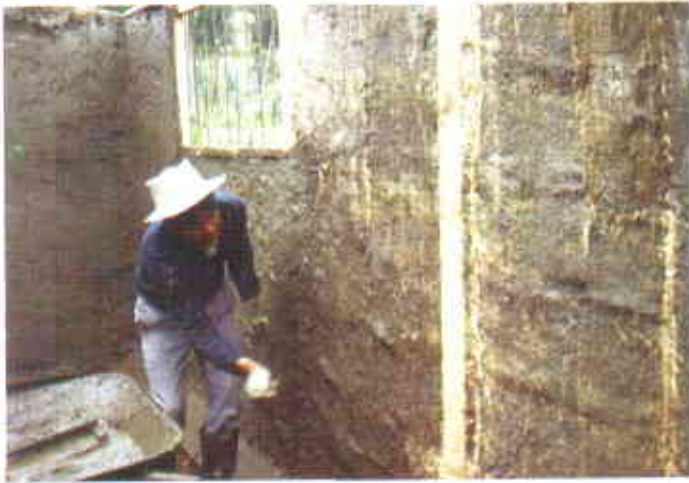
Figura 23. Champeado y repello de las paredes exterior. Para esta actividad se utiliza el codal y la llana que permiten dejar la pared aplomada y lisa.
