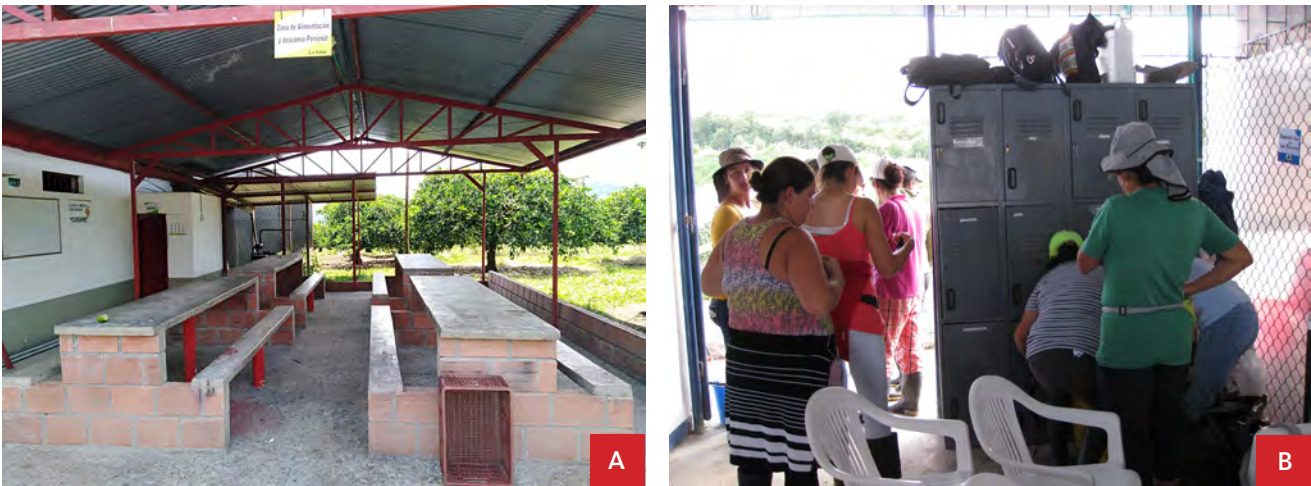
Figura 67. Infraestructura de apoyo a los trabajadores . A: Área para el consumo de alimentos y descanso. Fuente: Luz Adriana Vásquez. B: Área para guardar elementos personales. Fuente: Luz Adriana Vásquez.
