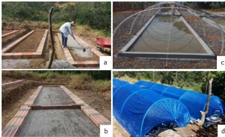
Figura 11. Construcción de piscina y túnel para semilleros estandarizados. a. Preparación superficie para piscina; b. Nivelación piscina; c. Llenado de piscina; d. Cobertura final semillero.
