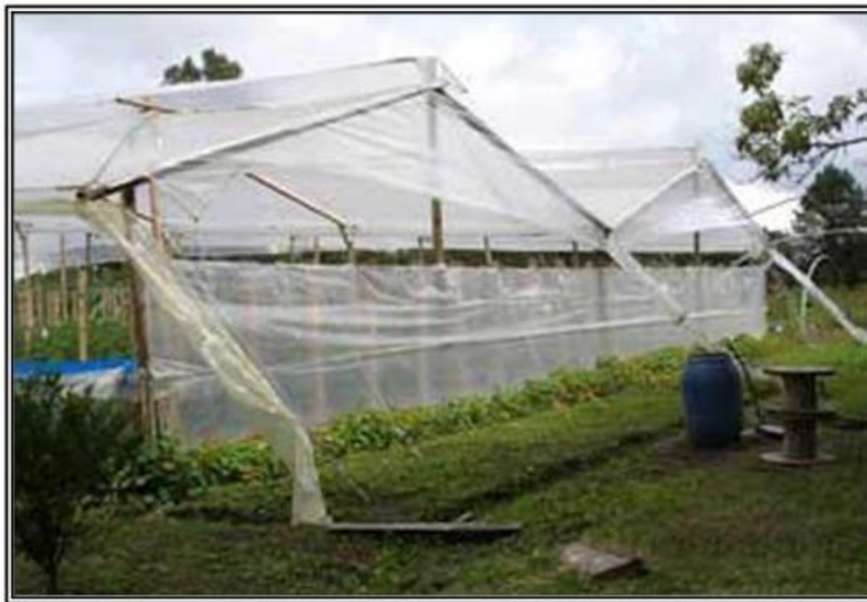
Figura 11. Invernadero tipo capilla
