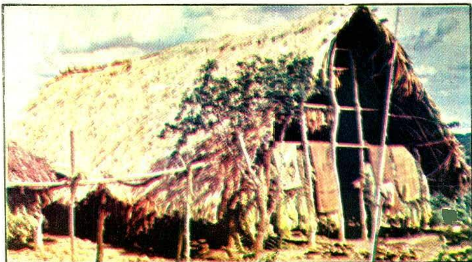
Fotografía 24: En la zona tabacalera de la Costa Atlántica, se construye el tipo de caney que se observa en esta fotografía. Su techo es de palma y su armazón en madera. Su estructura es rústica pero eficiente para un buen secado del tabaco.
