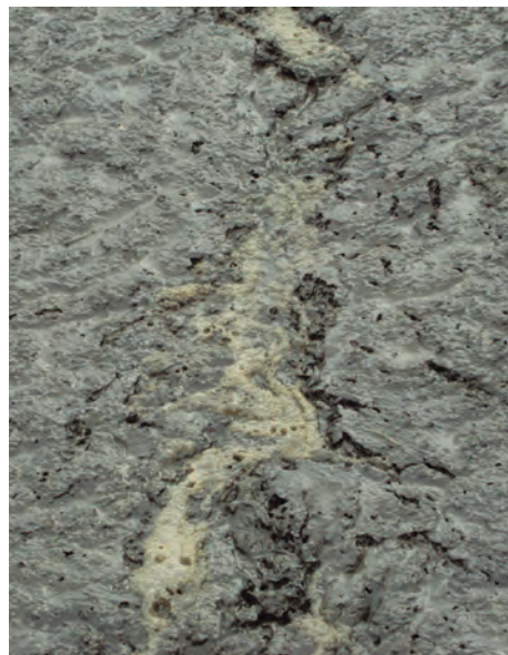
Figura 8 7 . Lodos estabilizados de fondo de laguna.
