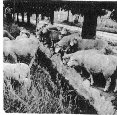
Zanja para suministro de agua, revestida de piedra y cemento.
