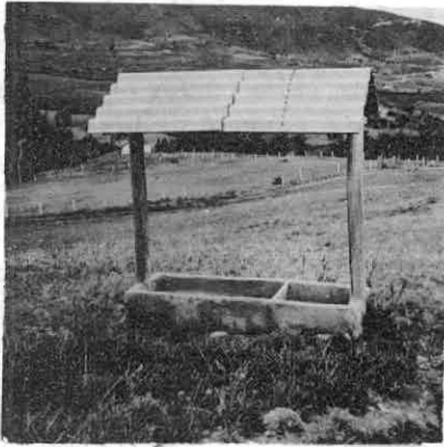
Saladero de la Granja de San Jorge, construido de ladrillo, cemento, 2 postes de madera y 4 tejas de Eternit.
