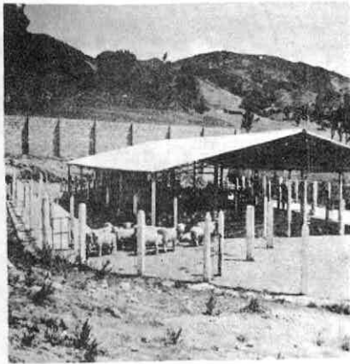
Aprisco en la Granja San Jorge, hecho a base de piso de cemento, postes de hierro, teja Eternit, corta vientos de ladrillo y corrales de malla.
