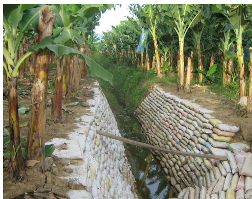
Figura 19. Estabilización de taludes con trinchos asociados con cobertura vegetal.
