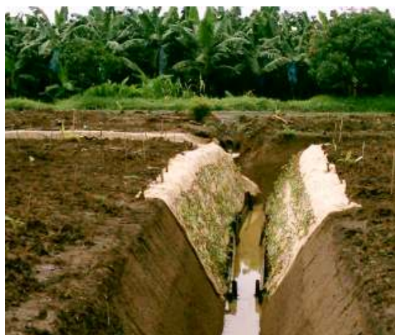
Figura 17. Protección de drenajes con geo textiles
