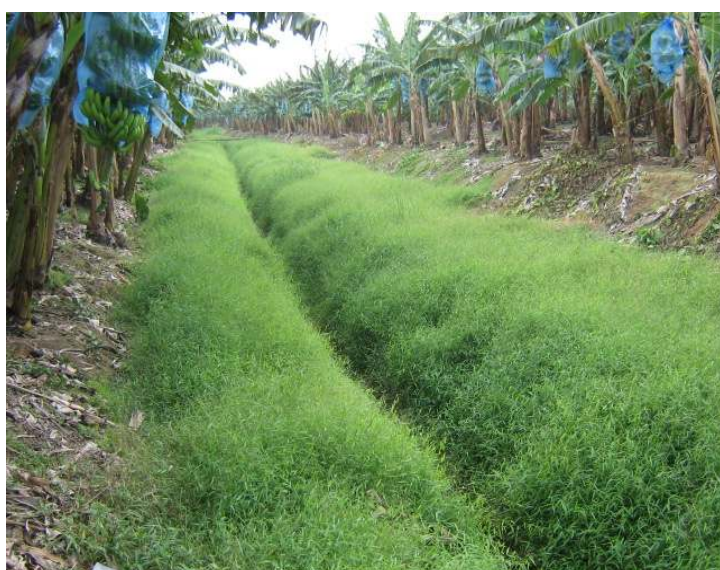
Figura 15. Canal de drenaje estabilizado y protegido con pasto alambrito
