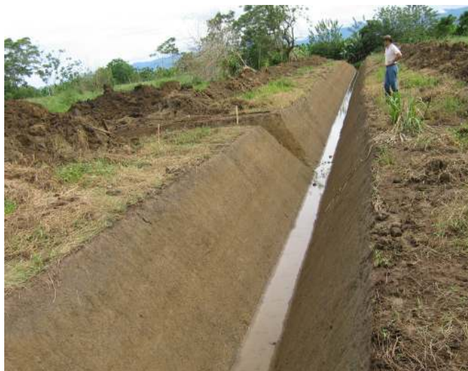
Figura 22. Construcción de canales de drenaje
