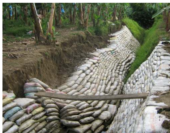
Figura 18. Construcción de trinchos para control de erosión en un canal de drenaje
