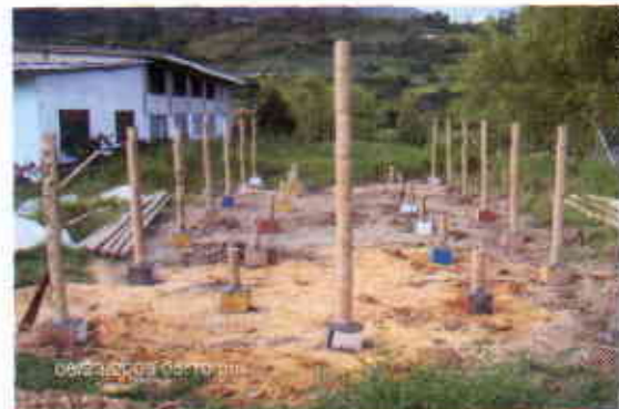
FIGURA 12. Vista isométrica de las columnas y los cimientos construidos para soportar la estructura de secado y la cubierta.
