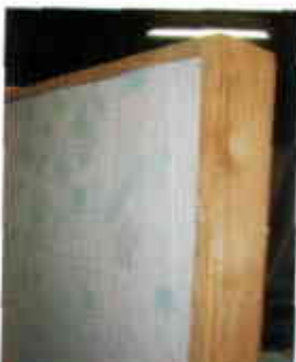
FIGURA 26. Paredes recubiertas de icopor como aislante térmico
