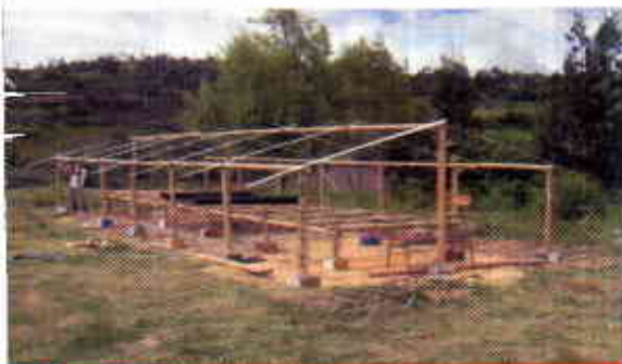
FIGURA 14. Ubicación de las latas de guadua para soportar la cubierta plástica.
