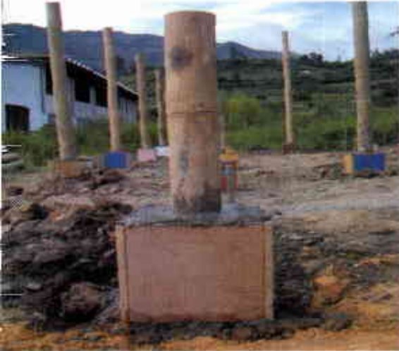
FIGURA 11. Vista alzada y en planta de las zapatas elaboradas para sostener la cama de guadua y la estructura general para el curado de cebolla
