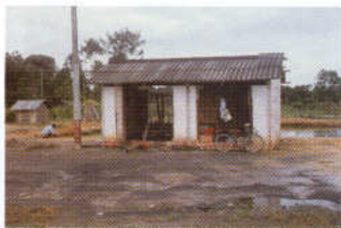
Foto 26. Caseta para guardar y controlar insumos y equipos.
