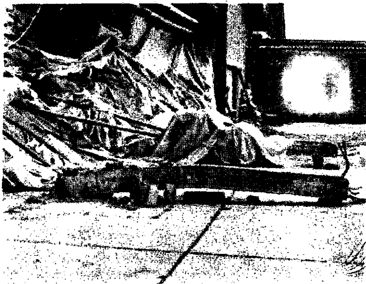
Fig. No. 8.5- Colapso estructural de bodega a granel
