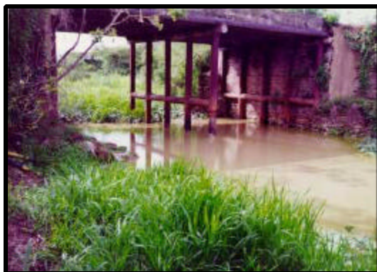
Foto 5.5 Sistema de puentes en la carretera Arauquita -Arauca Depresión río Arauca - caño Matanegra
