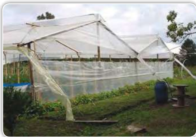
Figura 1.9. Invernadero tipo capilla
