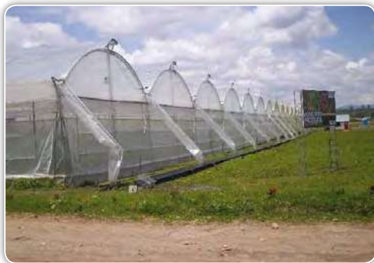
Figura 5.18. Drenajes al exterior del invernadero para evitar excesos de humedad
