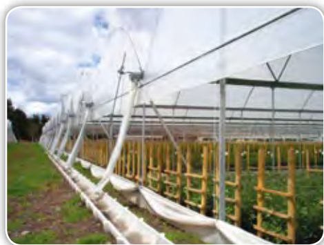
Figura 2.8. Ventana lateral descendente
