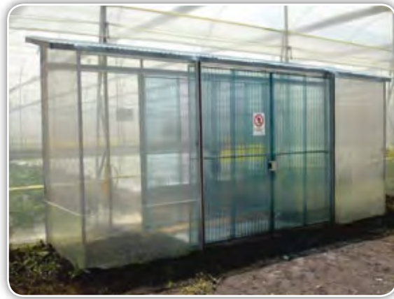
Figura 7.1. Doble puerta o precámara a la entrada del invernadero
