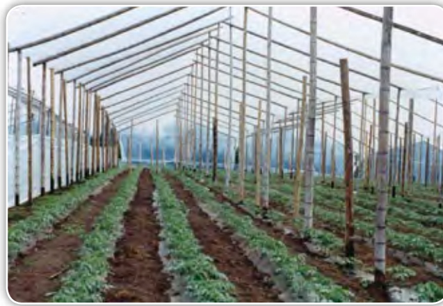
Figura 1.17. Invernadero construido con guadua
