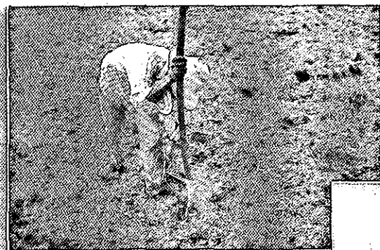
Figura 3.15. Siembra del material vegetativo de pastos en forma manual.
