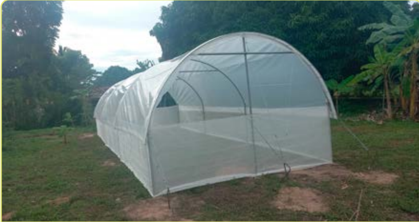
Figura 4.22. Instalación del plástico.
