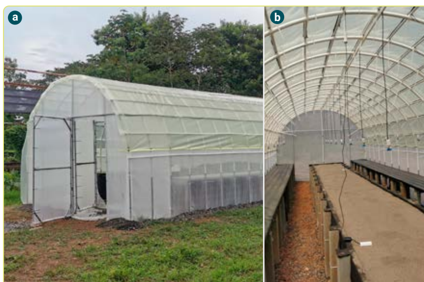
Figura 3.1. Túnel de multiplicación. a. Vista exterior; b. Vista interior.
