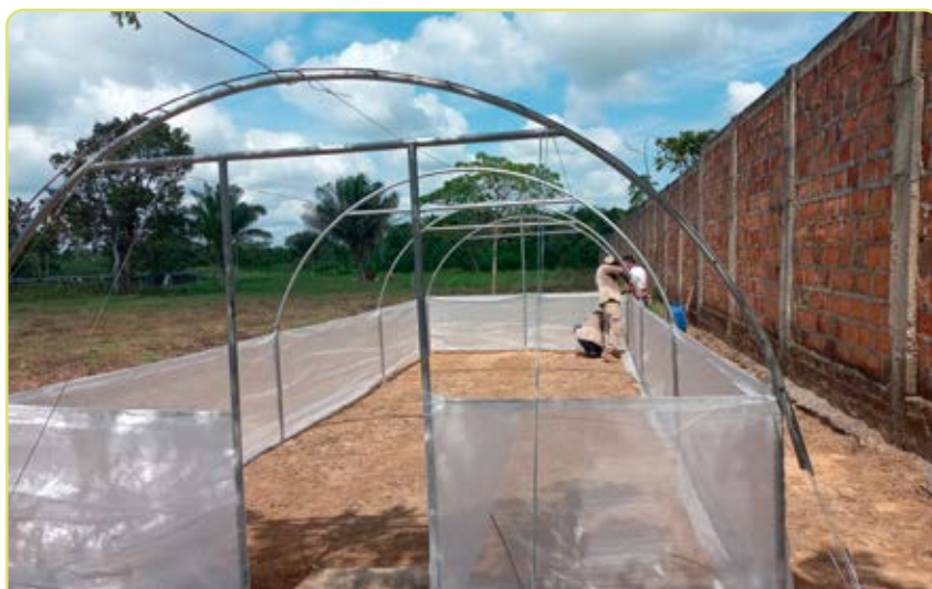
Figura 4.21. Instalación de la malla antitrips.
