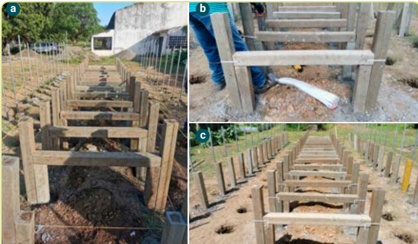
Figura 4.8. Instalación de los soportes de la cama central. a. Ubicación de la madera plástica para la instalación de la cama central; b. Amarre y aseguramiento de la madera plástica de la cama central con amarres laterales; c. Estado final de la cama central con amarres laterales y verticales.
