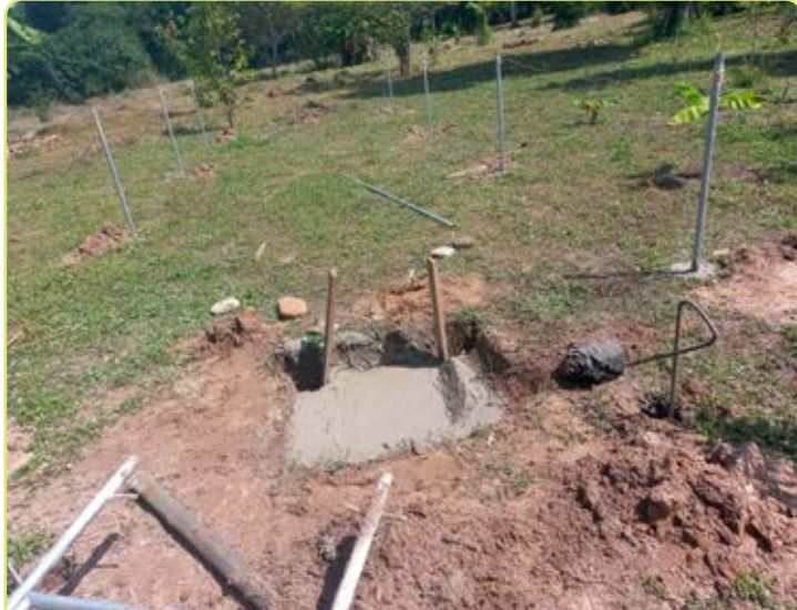
Figura 4.19. Bases, tensores y área de desinfección fundidos.
