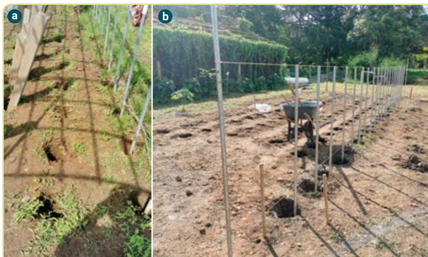
Figura 4.4. Instalación de la base del túnel de multiplicación rápida. a. Vista lateral de la disposición de los huecos para la instalación de la mesa y el túnel; b. Vista general de la nivelación de bases.
