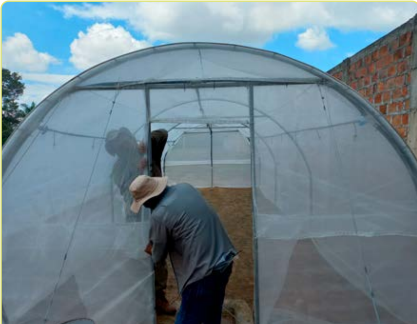
Figura 4.23. Retoques en la unión de la malla con el plástico.
