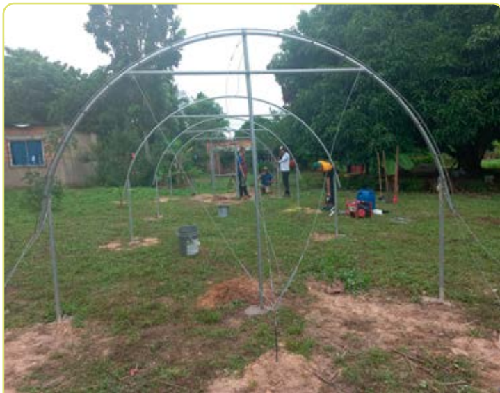
Figura 4.20. Instalación de arcos y tendido de guayas.
