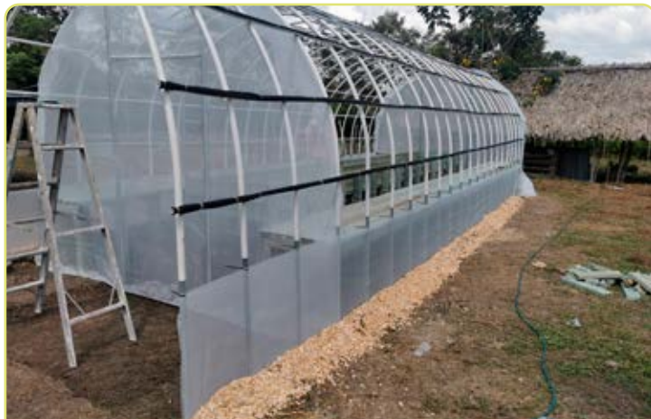
Figura 4.11. Instalación del plástico y la malla antiáfidos.
