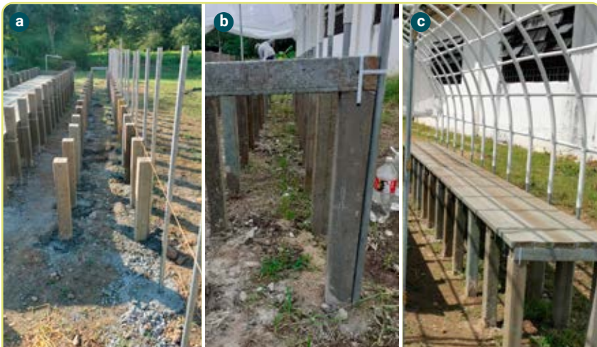
Figura 4.6. Instalación de las camas laterales. a. Instalación de los soportes; b. Amarre; c. Visión general de la mesa lateral instalada.
