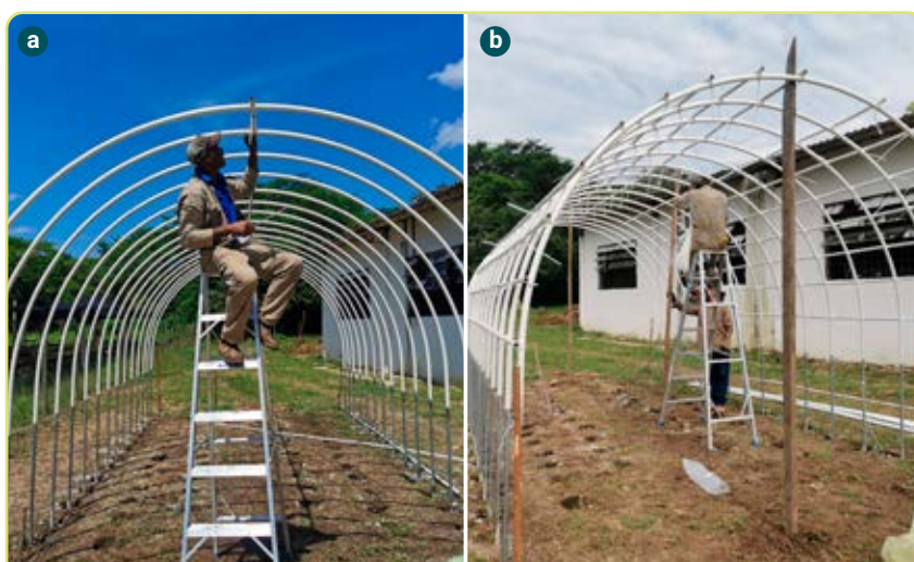
Figura 4.10. Instalación de la estructura del túnel de multiplicación con tubos PVC. a. Arcos con tubos PVC de 1" anclados a los tubos galvanizados de cada zapata; b. Estructura con tubería PVC 4/3" laterales, para amarrar los arcos. Esto da firmeza a toda la estructura.
