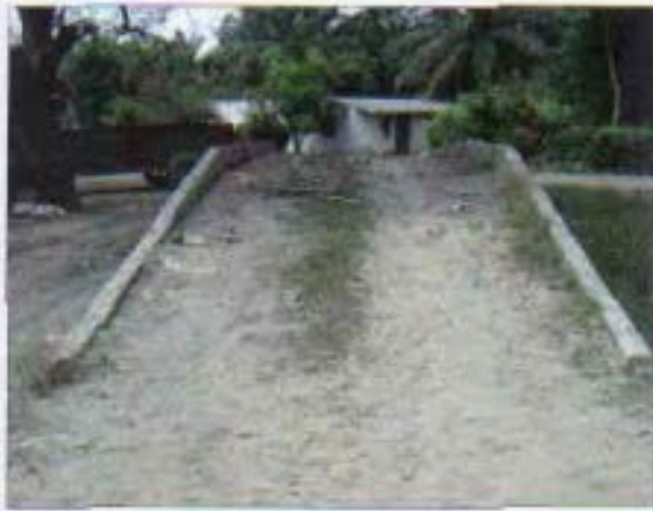
Figura 73. Rampa para el acopio transitorio de fruto antes del cargue al equipo de transporte secundario.
