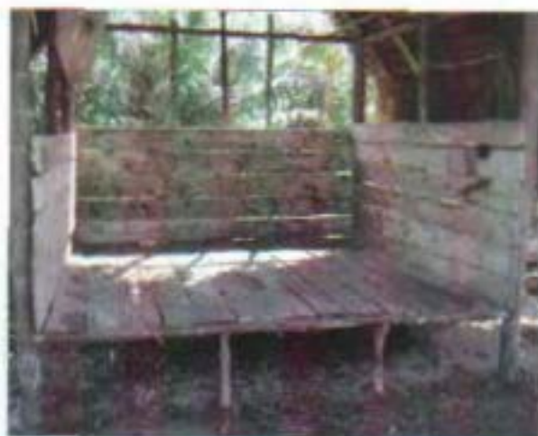
Figura 70. Acopio con base de madera y techo.
