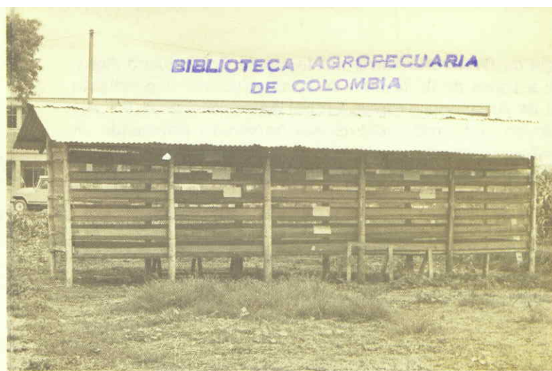
Silo. Utilizado para almacenar granos o semillas. Estructura a base de madera aserrada y malla plástica o anjeo.
