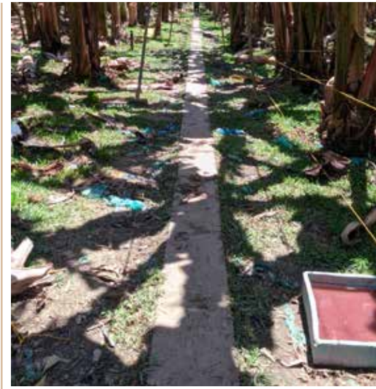
Figura 10. Vista de placa-huella en condiciones de campo.
