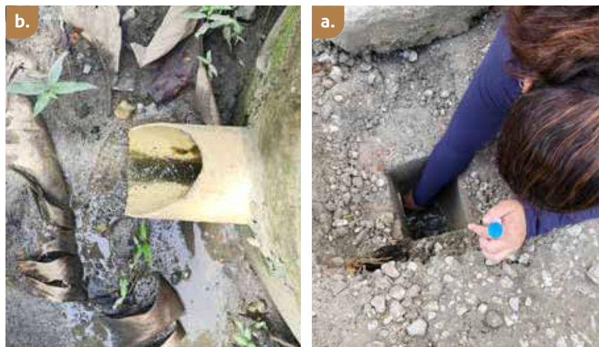
Figura 27. Procedimiento de muestreo en filtros de aguas residuales. a. Filtros finales de disposición de agua; b. Cajas de recolección de lodos.
