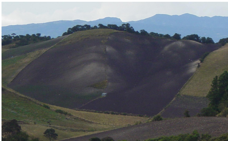
Figura 19 Erosión en lotes de ladera por efecto del mal uso de maquinaria e implementos en la preparación de suelos. Fuente: Núñez (2010a).
