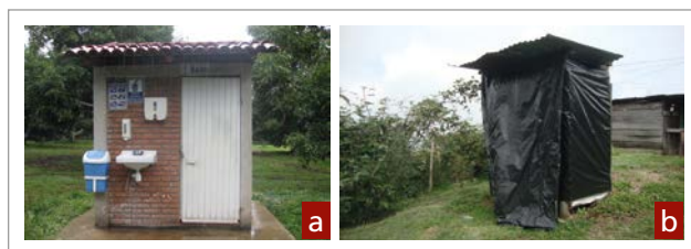
Figura 6.3. Unidades sanitarias y de aseo. a. Construcción en ladrillos; b. Construcción artesanal.
