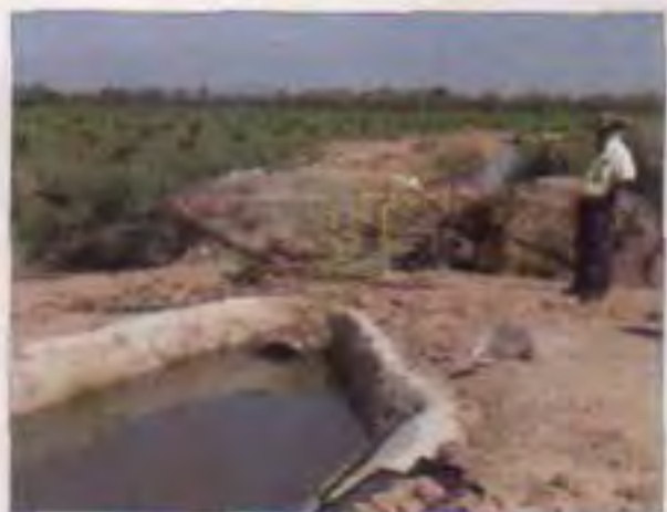
Figura 43. Inspección rutinaria de red de canales.
