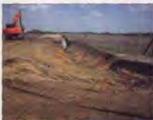
Figura 41. Excavación y distribución uniforme de residuos al costado del canal.
