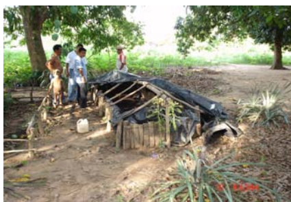
Fig 4. Módulo de madera en el piso.
