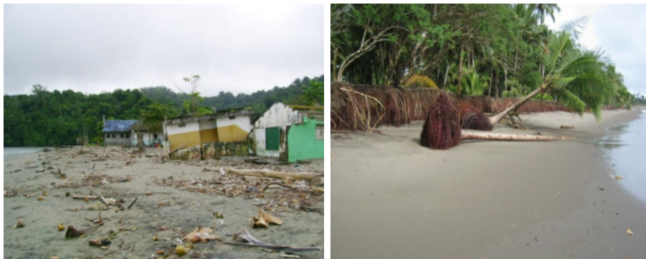
Figura 2.8. Viviendas colapsadas por la intensa erosión marina (izquierda). Palmeras desarraigadas y colapsadas; erosión del talud por escorrentía y socavación en las playas de Jurubirá (derecha).
