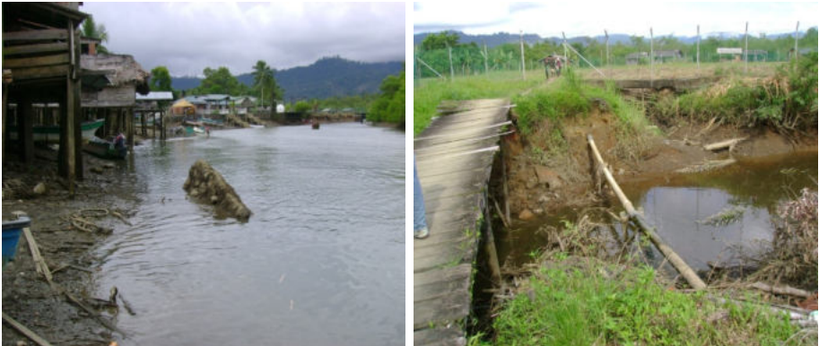
Figura 2.7. Erosión de orillas en el río Ancachí (izquierda). Erosión causada por un estero al lado de la pista de aterrizaje del aeropuerto de Nuquí (derecha).
