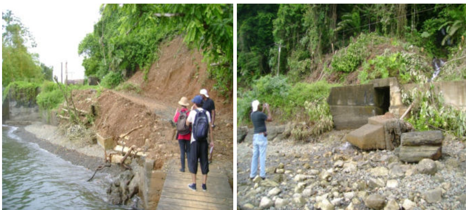
Figura 2.6. Movimientos en masa recientes en el depósito de coluvión, sector del puerto de la ESSO (izquierda). Box coulvert parcialmente colapsado debido a socavación lateral del talud (derecha).
