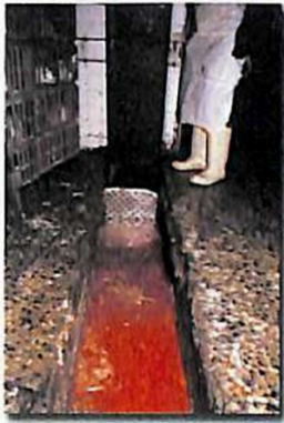
Aguas residuales de una planta de beneficio de aves canalizadas para su tratamiento
