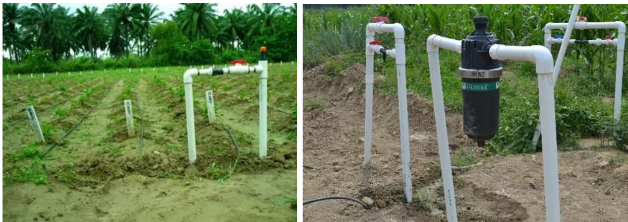
Figura 42. Vista del sistema de riego por goteo instalado en el cultivo de ají topito y detalles del desarrollo de las plantas.
