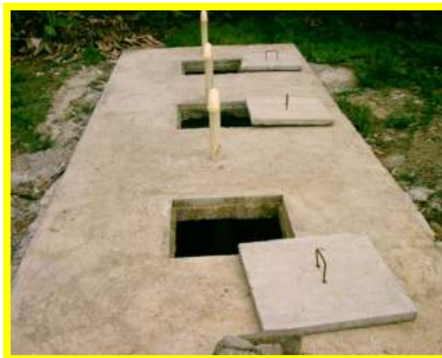
Foto 9. Ventilación preliminar del Pozo Séptico
