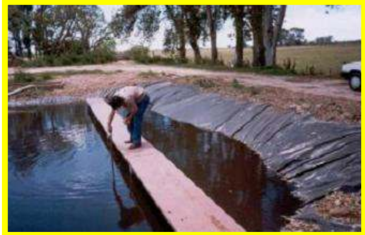
Foto. 2. Laguna de estabilización
