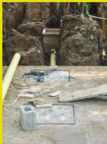
Tanque séptico en construcción
