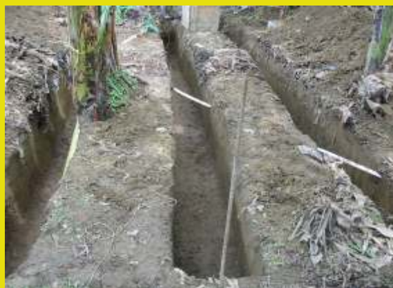
Zanjas de infiltración
