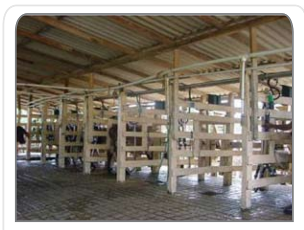
Figura 16. Aseo en el confinamiento. Obsérvese la terminación en cuadrículas, que le da seguridad al desplazamiento de los animales, aunque el piso esté húmedo
