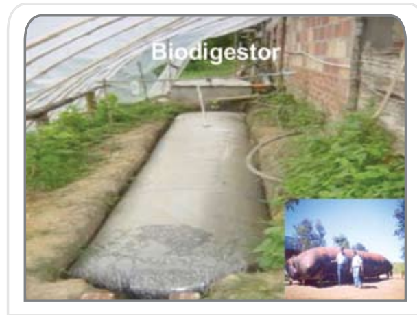
Figura 32. Campana de biogás
