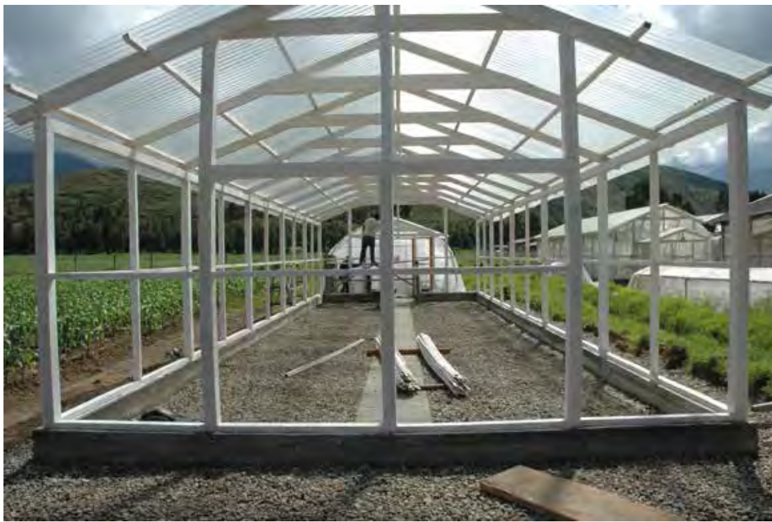
Distribución de las columnas de madera ancladas en el cemento en una casa de malla de 15 x 5 m y techo de policarbonato. CIP-Huancayo, Perú.
