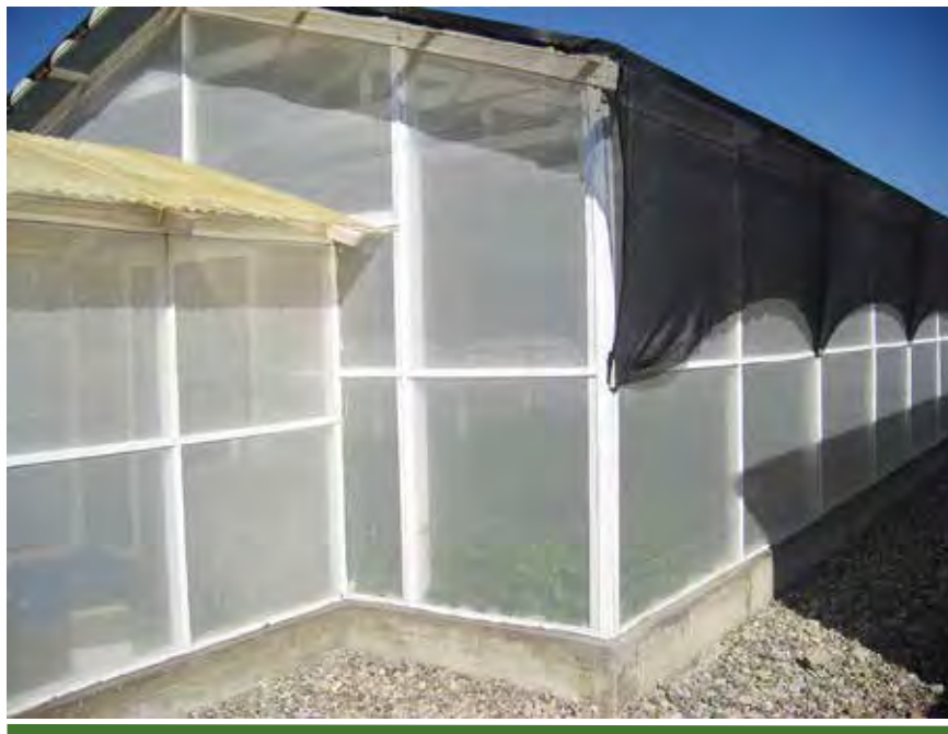
Malla sombreadora negra (50% de sombra), cubriendo el techo de policarbonato en CIP-Huancayo, Perú.
