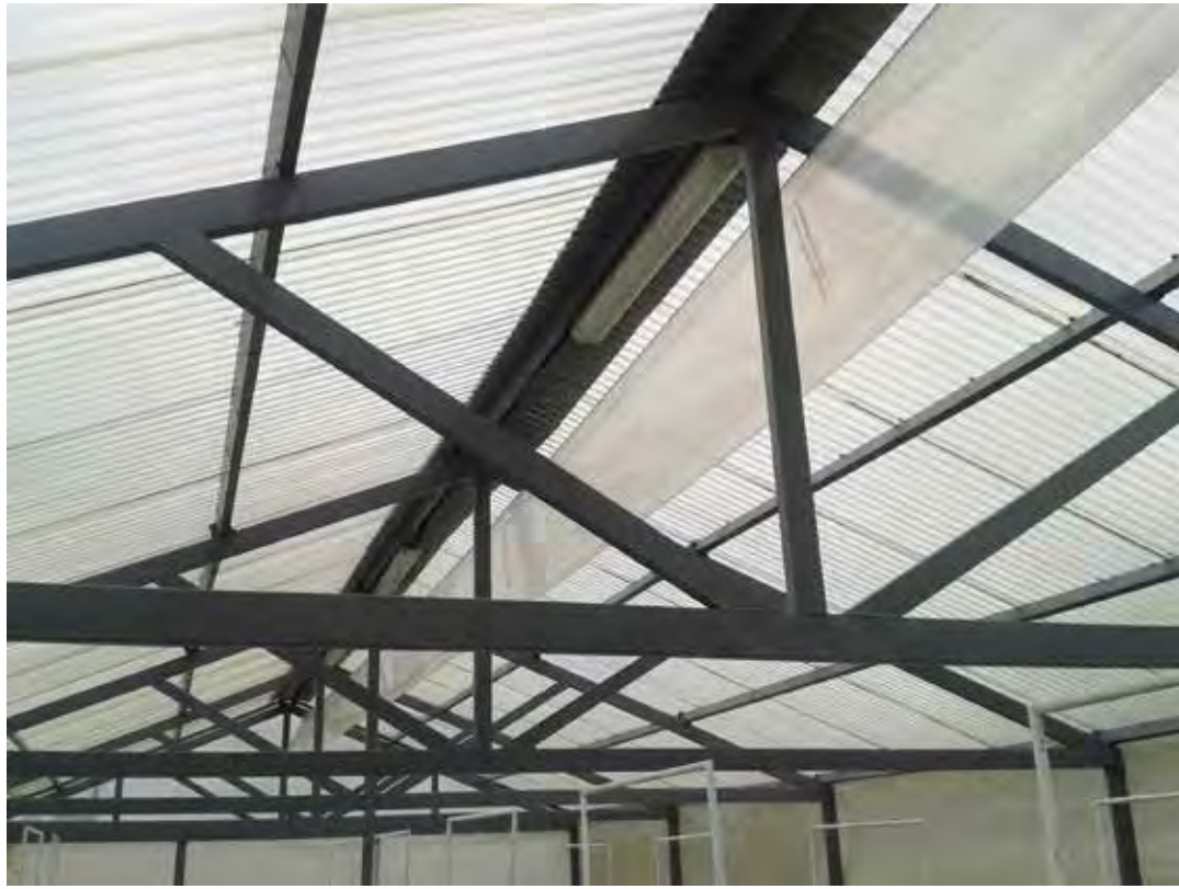
Casa de malla con estructura metálica. Corpoica-Tibaitatá, Colombia.
