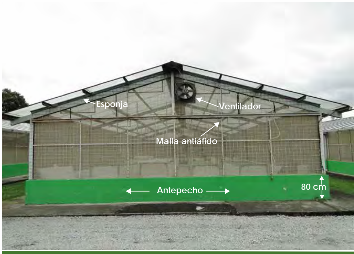
Casa de malla con paredes (antepecho) de 0,8 m de altura y malla antiáfido, CIP-Quito, Ecuador.
