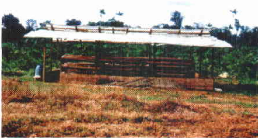
Figura 13. Vista general de invernadero de germinación
