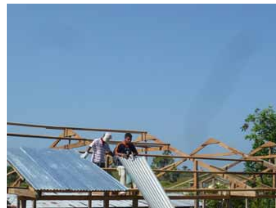
Colocación de la cubierta
