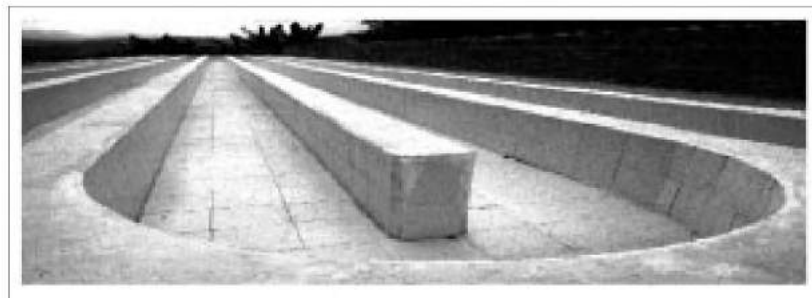
Foto 26A-11. Canales para sedimentar el almidón (ver S. T. en Foto 26A-4).
