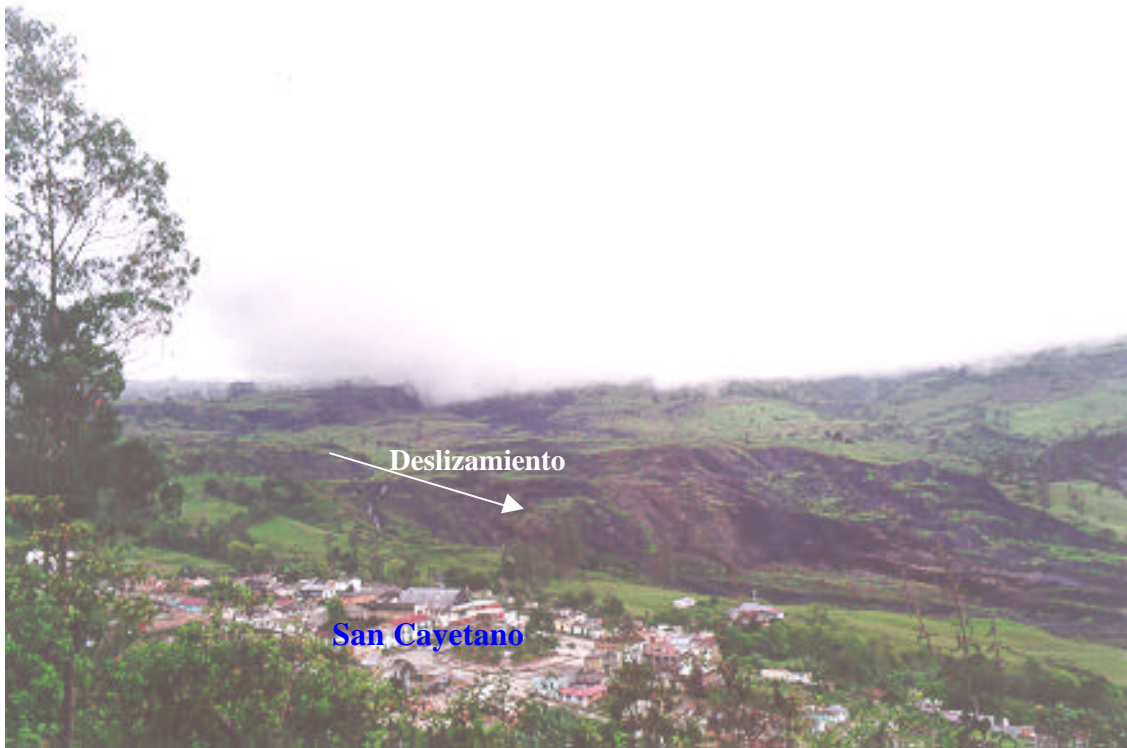
Vista panorámica del pueblo de San Cayetano afectado por un deslizamiento, evacuado el 12 de mayo de 1999 y reubicado un año después.
