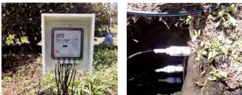
Figura 49. Instalación de sensores de humedad.
