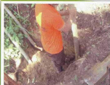
Foto 25. Ubicación de estacas
