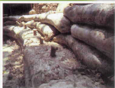
Foto 30. Sacos fijados por estacas
