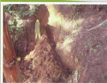
Foto 24. Excavación para nivelar el trincho
