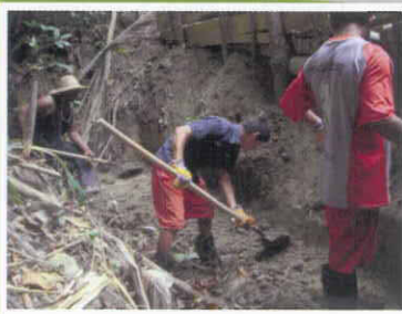
Foto 28. Limpia del terreno
