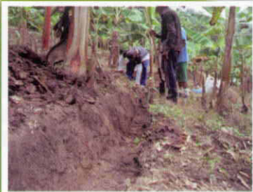
Foto 17. Excavación hecha por las marcas
