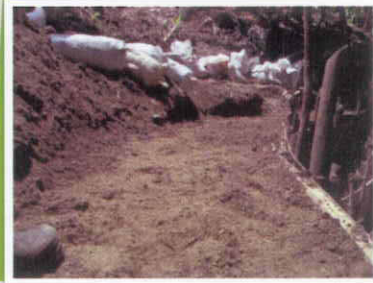
Foto 33. Relleno de la terraza
