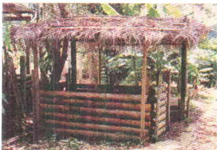
Figura 3. Cajas de almacenamiento.
