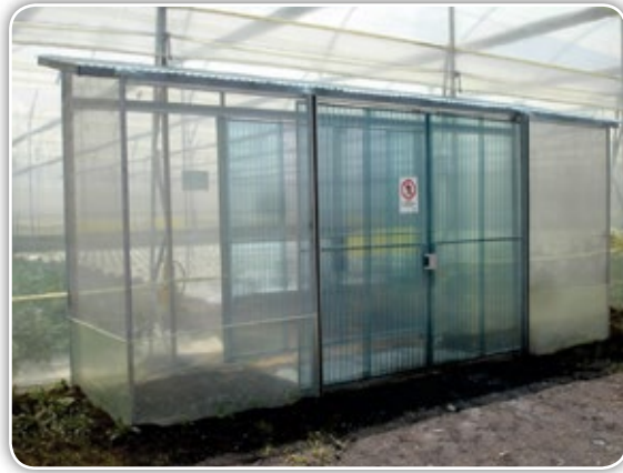
Figura 7.1. Doble puerta o precámara a la entrada del invernadero
