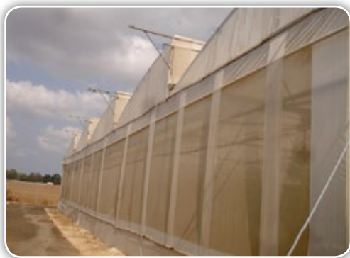
Figura 7.9. Invernadero climatizado con malla anti-insectos
