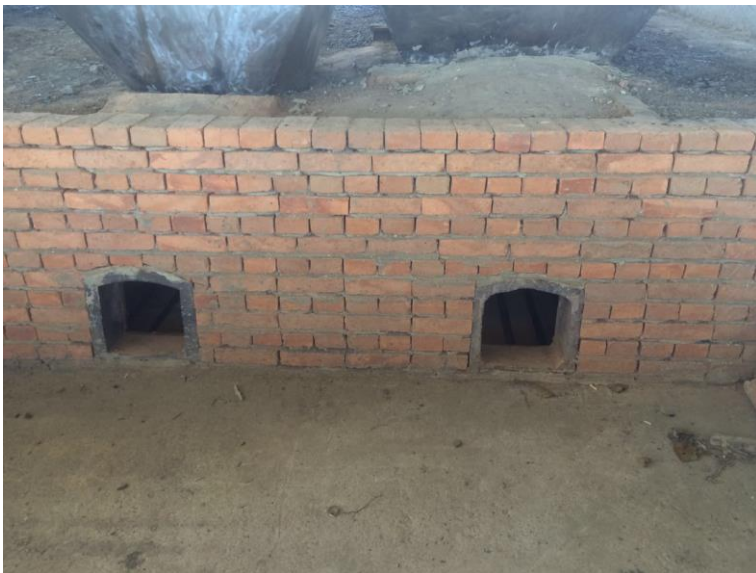
Figura 72. Puerta para la alimentación del combustible a la hornilla.
