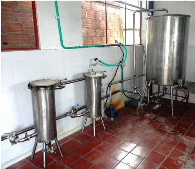
Figura 79. Filtro de mangas a presión.
