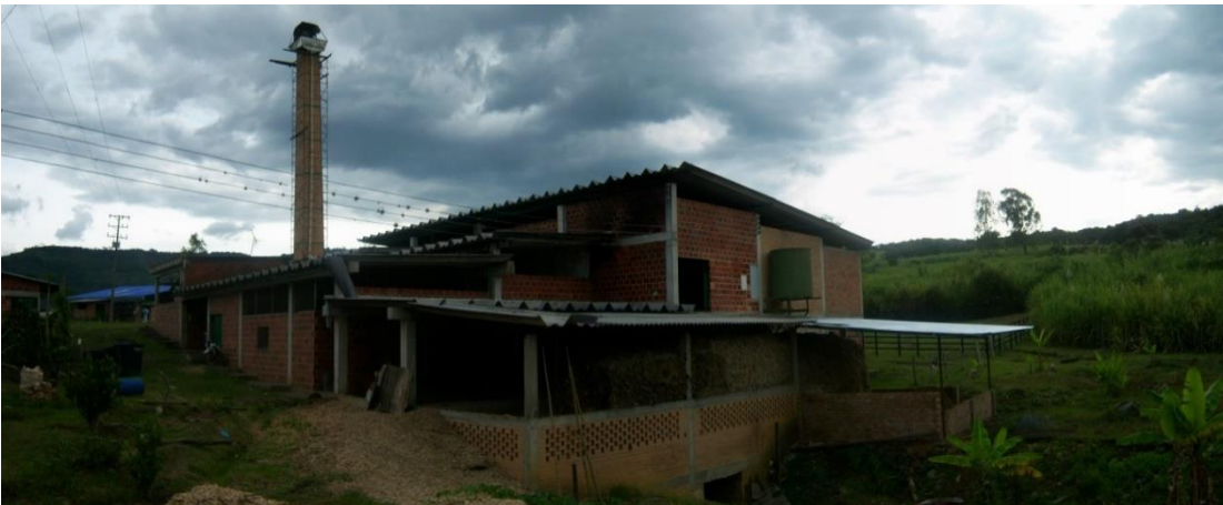
Figura 71. Instalación de hornilla panelera (tipo Cimpa) de la HRS.
