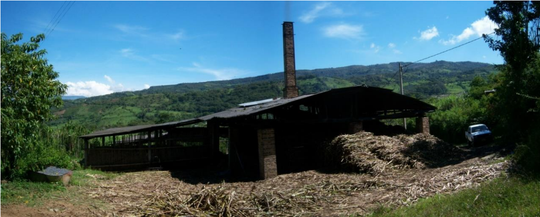
Figura 70. Instalación de hornilla panelera (tradicional) de la HRS.
