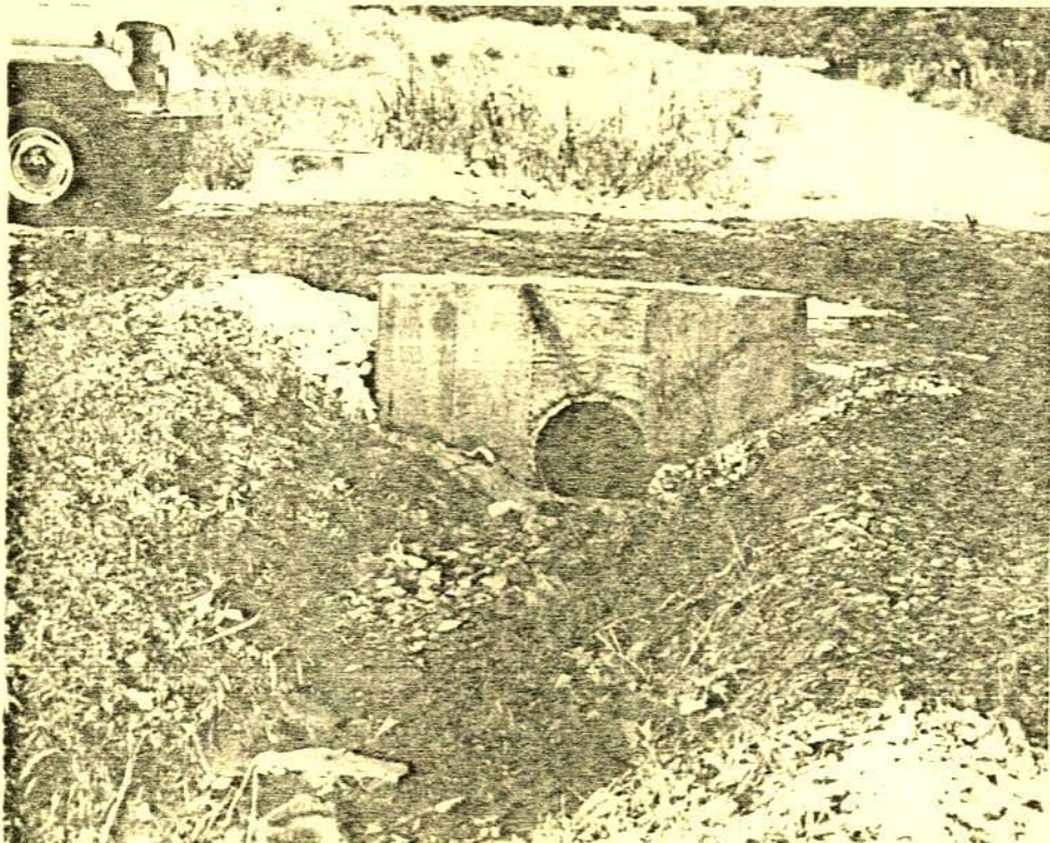
ALCANTARILLA CONSTRUIDA - SALIDA
