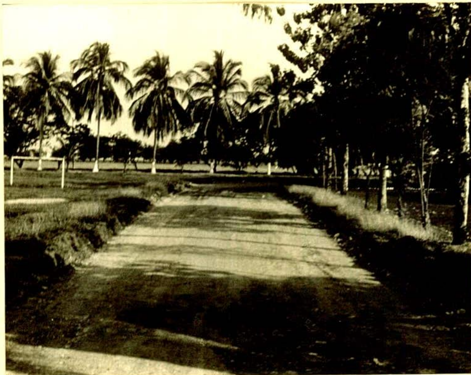
CONSTRUCCION DE VIA PARA PAVIMENTO
