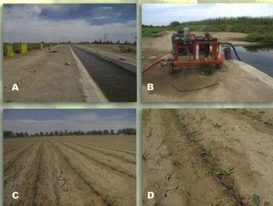
Figura 18. Instalación riego por goteo en el cultivo de alcachofa. A) Canal de riego. B) Equipo portátil de riego. C y D) Instalación de tubos y goteros en el cultivo.
