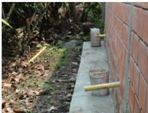
Figura 131. | Recolección de lixiviados mediante drenado fuera del cuarto de almacenamiento Foto: Autores
