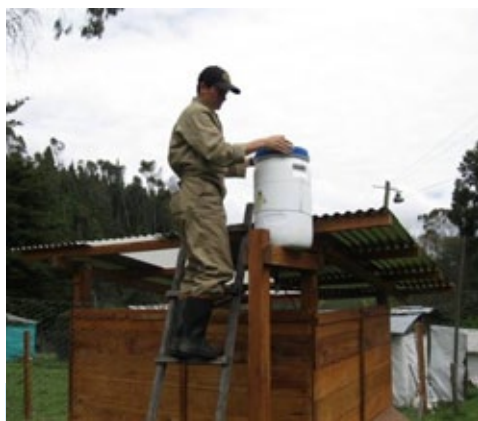
Figura 7. Tanque para suministro de agua por gravedad.
