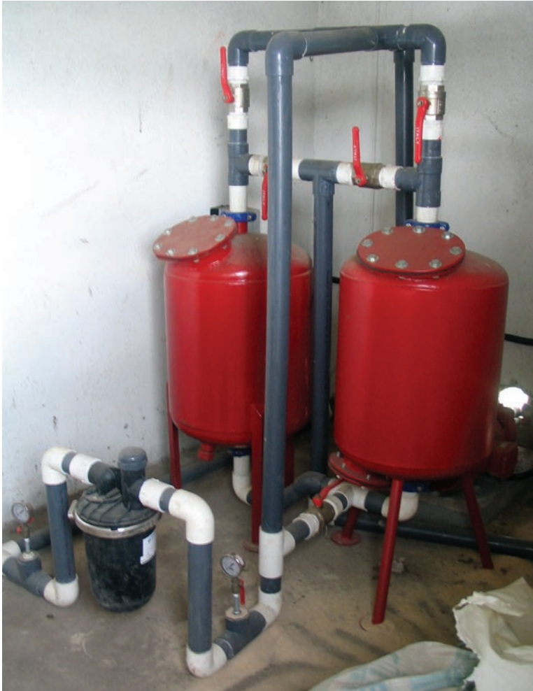
FIGURA 28. CONJUNTO DE FILTROS DE ARENA.
