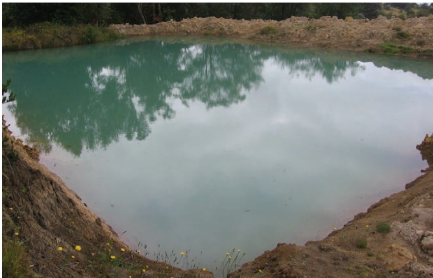
FIGURA 17. RESERVOIRIO DE AGUAS LLUVIAS COLECTADAS CON BASE EN CUBIERTAS DE INVERNADEROS.
