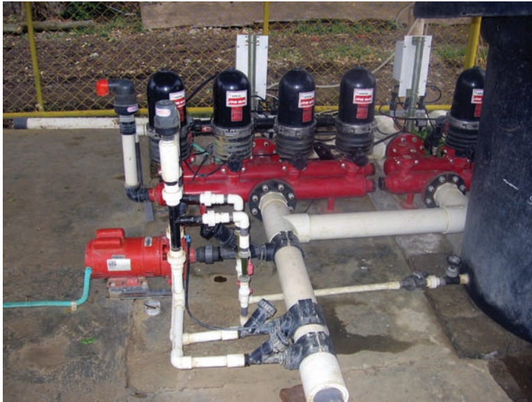
FIGURA 27. CABEZAL DE CONTROL O BOMBEO PARA UN SISTEMA DE RIEGO POR GOTEO PARA TOMATE EN LA SABANA DE BOGOTÁ.
