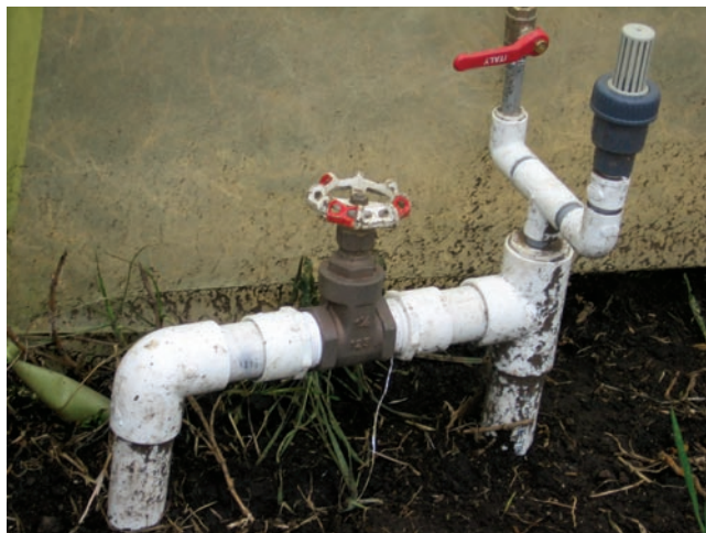
FIGURA 31. VÁLVULA DE DISTRIBUCIÓN Y VÁLVULA DE ALIVIO DE AIRE.
