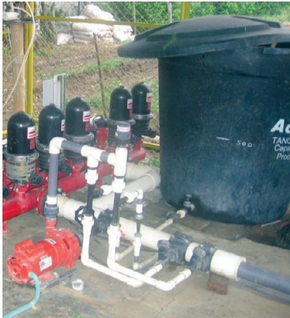
FIGURA 38. TANQUE DE FERTILIZANTES (OBSERVE LA MARCA DE 500 L, LA CUAL DEPENDE DE LAS CONDICIONES AGRONÓMICAS Y DIMENSIONES DEL CULTIVO).
