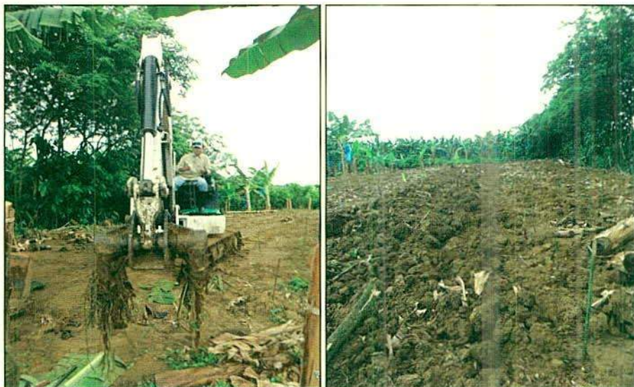
Figura 15. Descompactación del suelo al momento de realizar la renovación.
