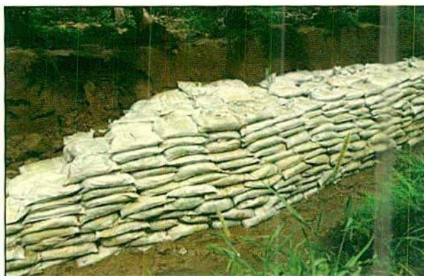
Figura 25. Practicas de estabilización de taludes con el uso de trinchos.
