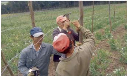
Tensado de alambre
