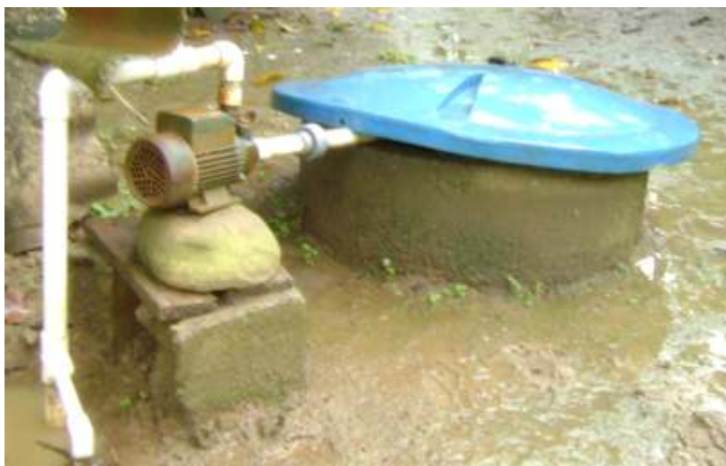
Figura 3. Sistema captación de agua para proceso de poscosecha en plátano (Pozo de agua superficial).
