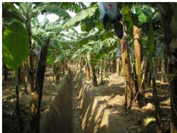
Figura 5. Drenaje superficial adecuado que permite evacuar el agua superficial y subterránea.
