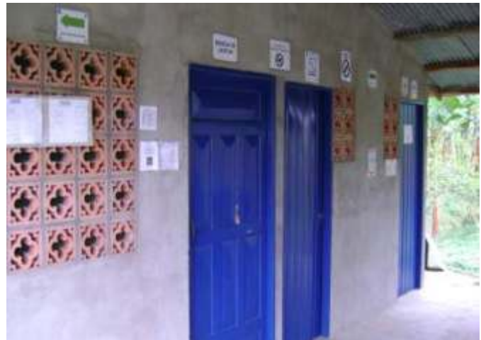
Figura 7. Instalaciones adecuadas para el almacenamiento de plaguicidas.
