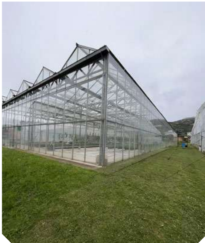
Figura 20. Invernadero tipo venlo con cubierta de vidrio.
