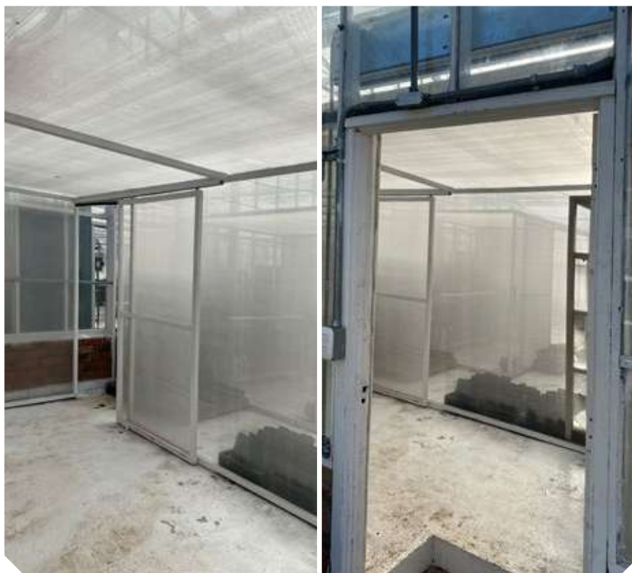
Figura 64. Área de ingreso en invernadero tipo venlo con cubierta de policarbonato.
