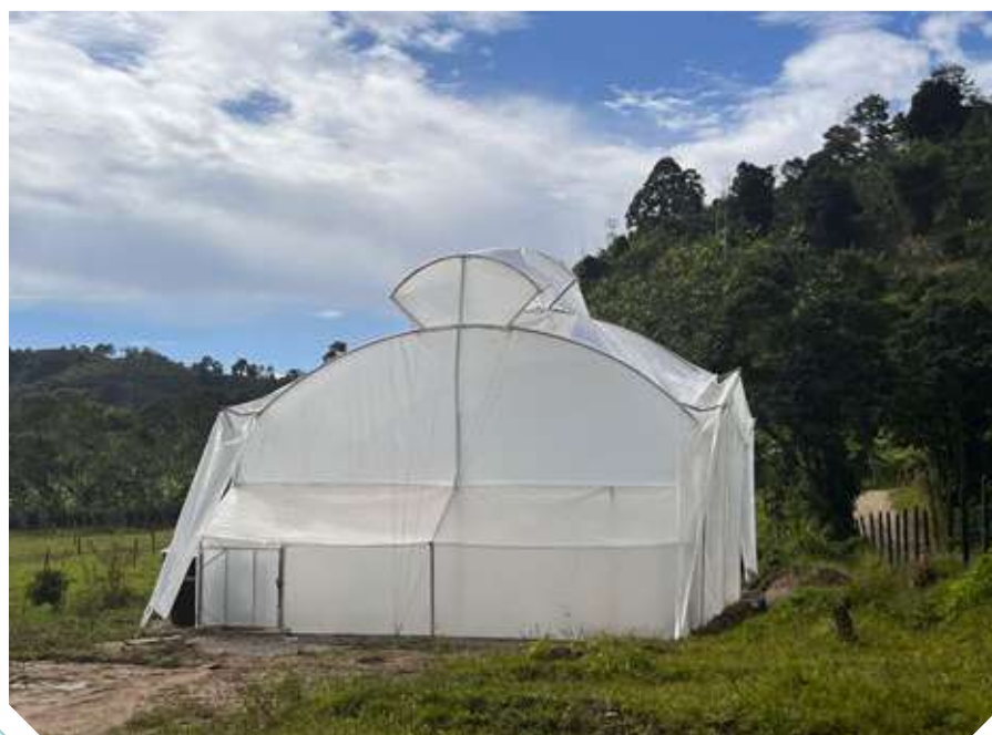
Figura 21. Invernadero tipo túnel monotramo con cubierta plástica.
