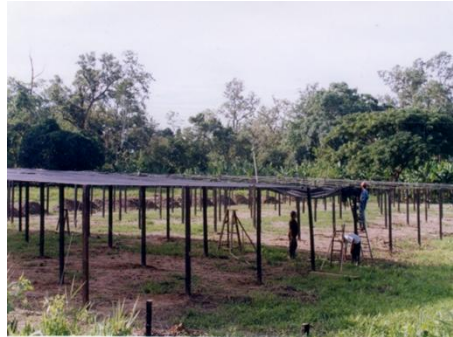
Montaje de la estructura
