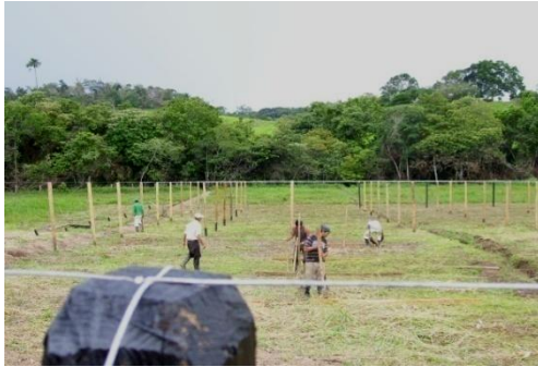
Adecuación del terreno
