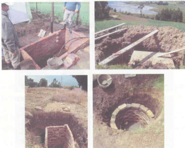
Figura 10.3. Elaboración del pozo séptico para la unidad sanitaria.
