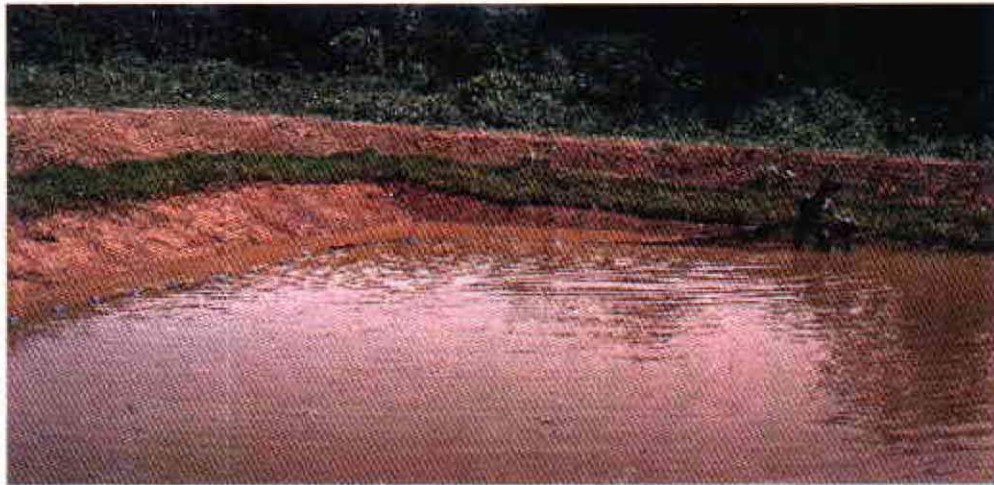
FIGURA 23. Cobertura del dique para protección.
