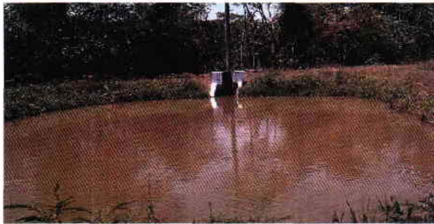
FIGURA 33. Estanque desagüe tipo monje
