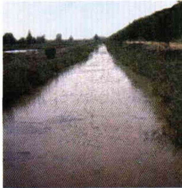
FIGURA 25. Canal de derivación
