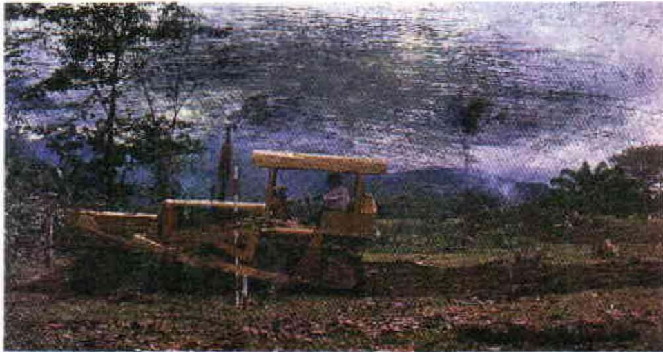
FIGURA 19. Descapote de un terreno para construir estanques
