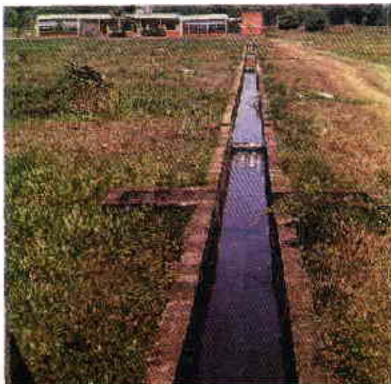
FIGURA 30. Canal abierto de alimentación de estanques
