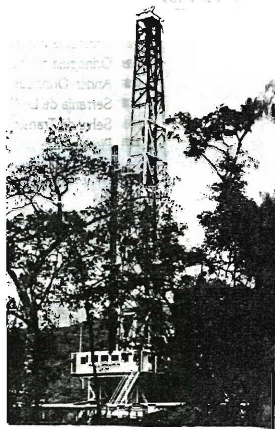
Torre petrolera en el campo de Cusiana, departamento de Casanare.
